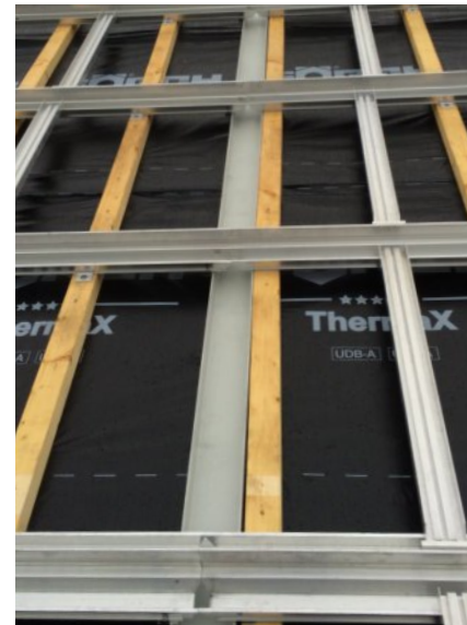
Unterkonstruktion: ClickPlain Indach Montagesystem
